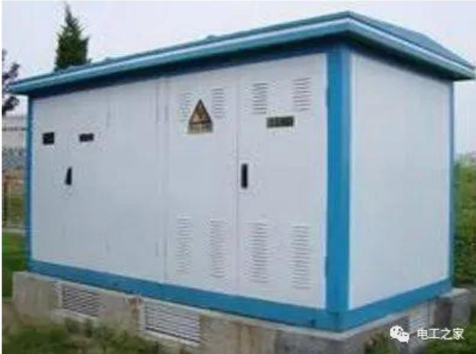
高压室紧凑合理,并具有全面防误操作联锁功能。变压器在用户有要求时,可设有轨道能方便地从变压器两侧大门进出。各室内均有自动照明装置,另外高、低压室所选用全部元器件性能可靠、操作方便、使产品运行安全可靠、维护方便。
